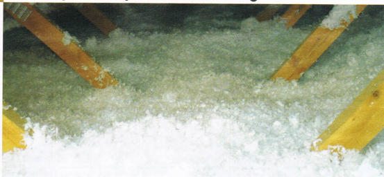
Chantier d'isolation écologique
